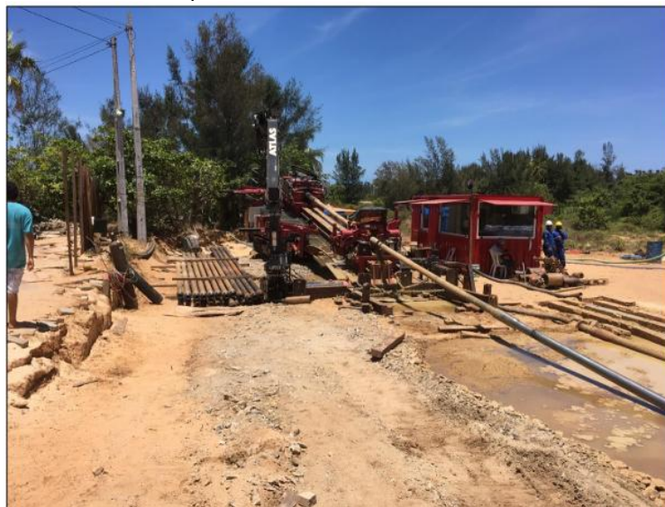
Figura 3: Instalação de tubulações no Lagamar do Cauípe para captação de água destinada ao complexo industrial do Pecém.
